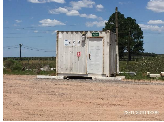
Ilustración 5 – Obrador secundario desafectado Container para laboratorios de suelos
