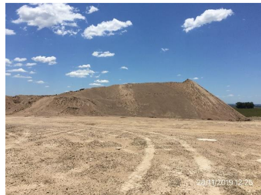
Ilustración 9 – Obrador principal – Acopios de material granular triturado.
