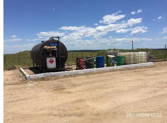
Ilustración 11 – Obrador principal – recinto para acopio de emulsiones y lubricantes con valla perimetral
