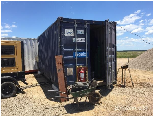
Ilustración 12 – Obrador principal – Pañol.
