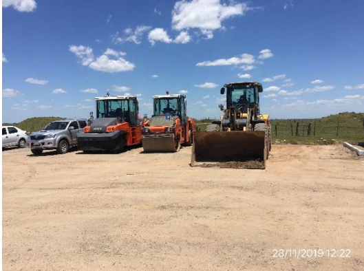
Ilustración 10 - Obrador principal –estacionamiento de maquinaria
