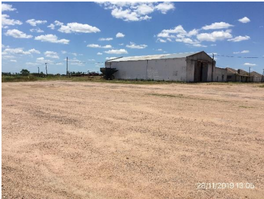
Ilustración 6 – Obrador secundario desafectado – Mejoras en pavimentos para usufructo del propietario.
