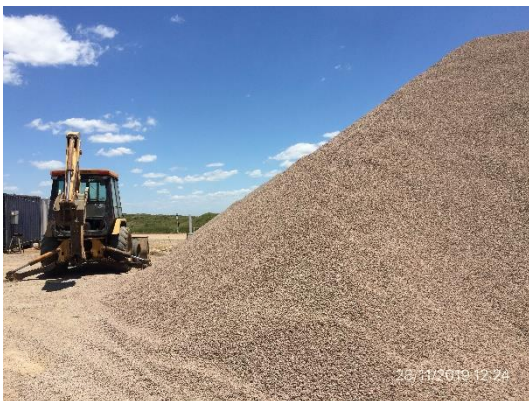
Ilustración 8 – Obrador principal – Acopios de material granular triturado.
