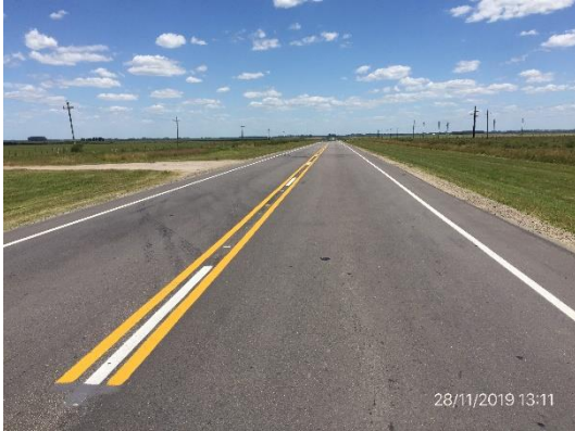
Ilustración 16 – Tramo de Ruta 18 terminado.
