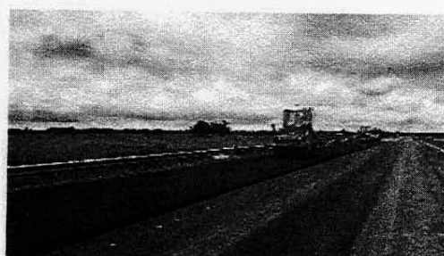
compactación de la mezcla
