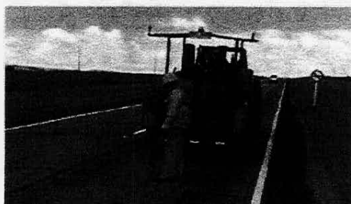
selladora de grietas
