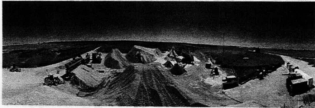
Vista general de la trituradora, planta asfáltica y demás instalaciones
