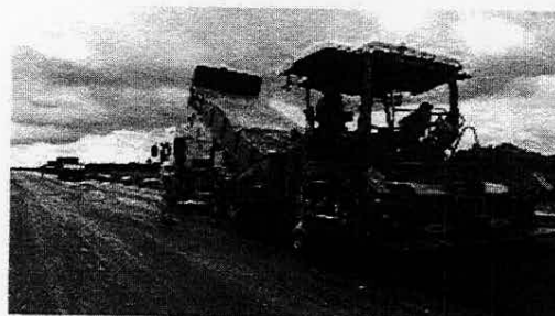
colocación de mezcla
