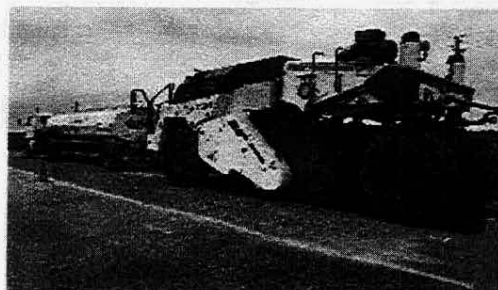
reciclado de pavimento con cemento
