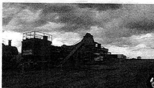
vista general planta asfáltica
