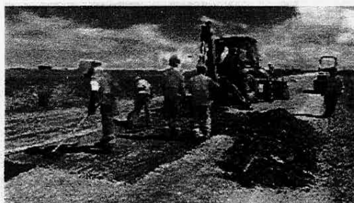
bacheo en calzada
