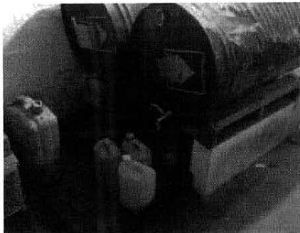
sistema de bandejas con arena para evitar derrames
