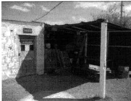
vista exterior de la sede de Mariscal
