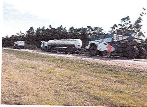
reciclado de pavimento con cemento
