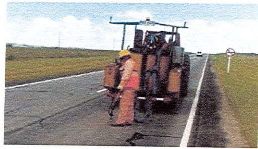
selladora de grietas
