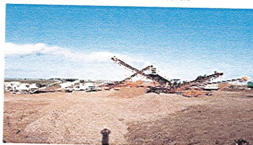
vista general planta trituradora
