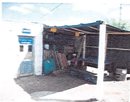
vista exterior de la sede de Mariscal
