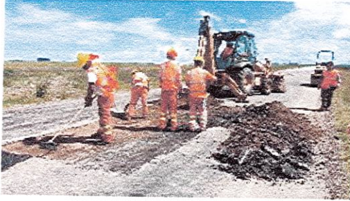
bacheo en calzada
