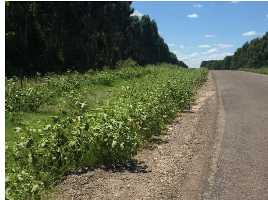
Ilustración 7 - Tramo de Ruta 20, recuperación de faja pública
