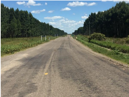
Ilustración 6 – Tramo de Ruta 20, recuperación de faja pública
