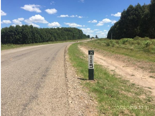
Ilustración 4 – Frente de obra – Fin de tramo progresiva 115K000
