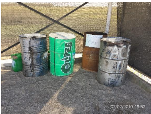
Ilustración 6 – Obrador secundario. Depósito de lubricantes usados con envallado y pavimento.
