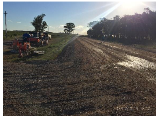
Ilustración 15 – Frente de obra Ruta 18, progresiva 237K000.
