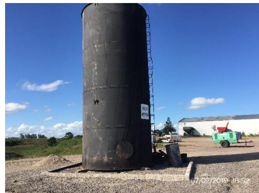
Ilustración 7 – Obrador secundario. Depósito de emulsión con contención insuficiente.
