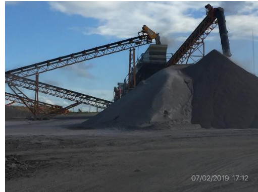
Ilustración 11 – Cantera – planta de trituración
