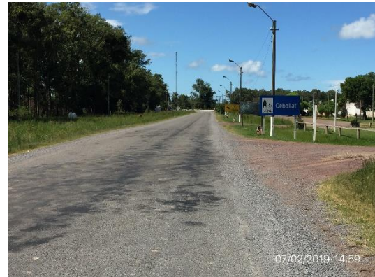
Ilustración 7 – Fin del tramo, Ruta 15 progresiva 195K000, localidad de Cebollatí
