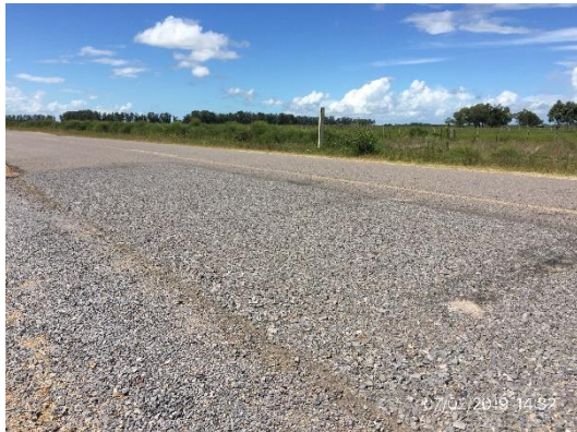
Ilustración 6 - Tramo con mantenimiento realizado.
