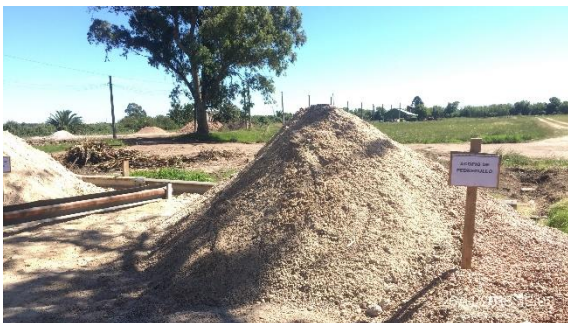
Ilustración 8 – Obrador: acopio de áridos
