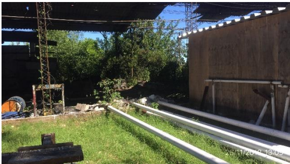
Ilustración 6 – Obrador: acopio de estructuras metálicas.
