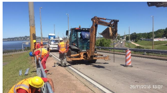
Ilustración 9 – Frente de obras.
