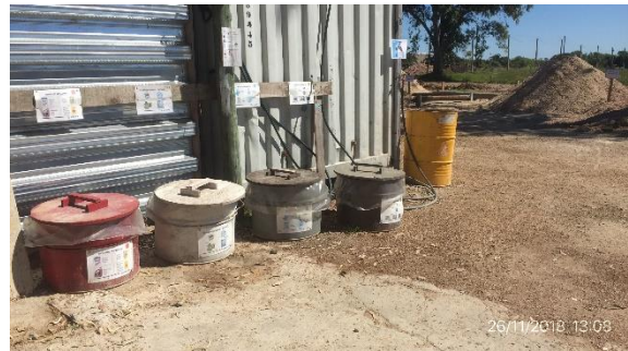
Ilustración 7 – Obrador: canales de residuos segregados.
