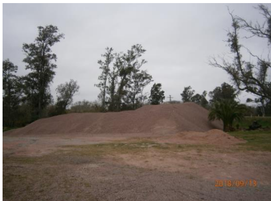
Ilustración 8 – Acopio en el obrador.
