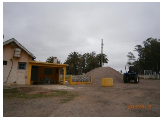
Ilustración 9 – Acopio en el obrador.
