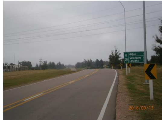
Ilustración 5 - Tramo de obra en Ruta 39.
