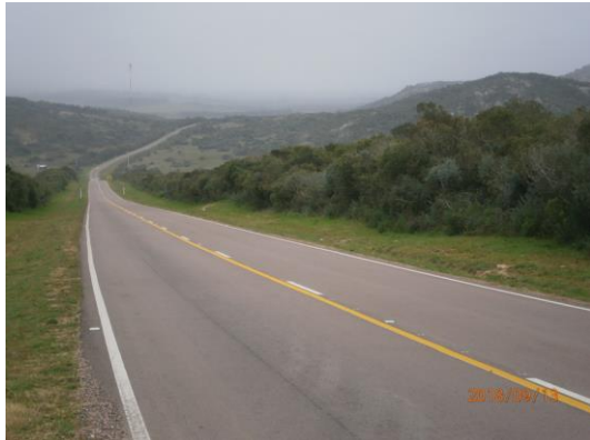
Ilustración 4 - Tramo de obra en Ruta 39.
