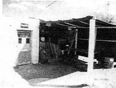
vista exterior depósito de Mariscal
