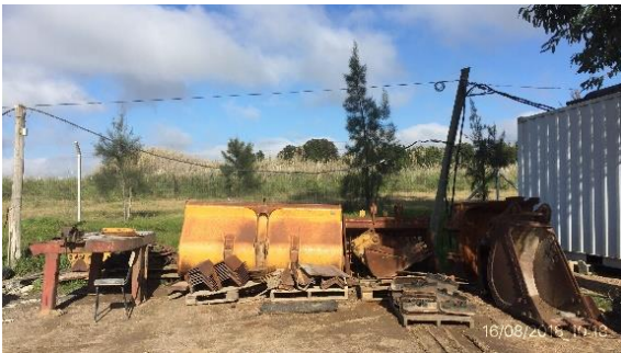
Ilustración 14 - Obrador CVC. Acopio de chatarra
