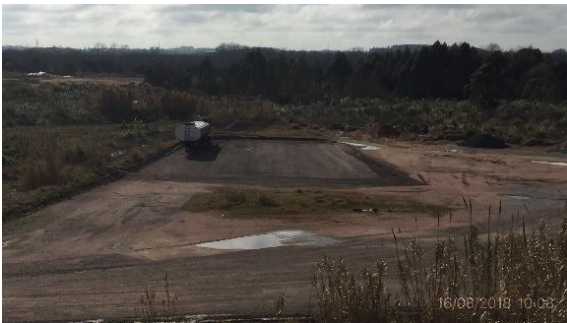
Ilustración 8 – Obrador CVC - Explanada acondicionada para acopio de emulsiones asfálticas
