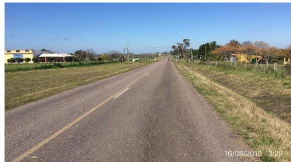
Ilustración 17 – tramo de Ruta 46 recuperado
