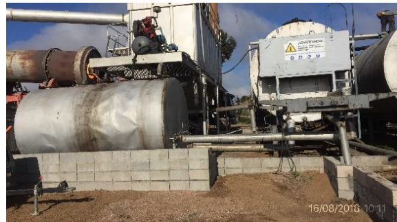
Ilustración 9 - Obrador CVC – planta asfáltica con envallado perimetral
