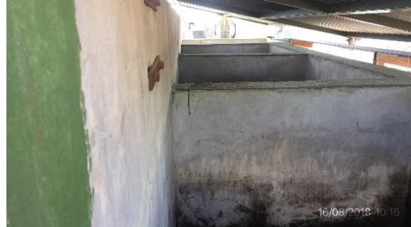
Ilustración 13 - Obrador CVC. Cámara sedimentadora
