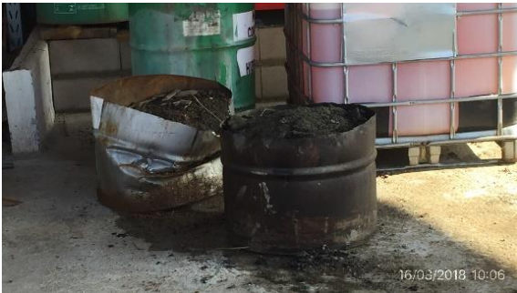
Ilustración 6 - Obrador CVC – acopio de áridos contaminados con lubricantes
