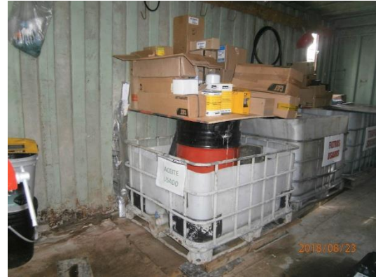
Ilustración 6 - contenedor para depósito de lubricantes
