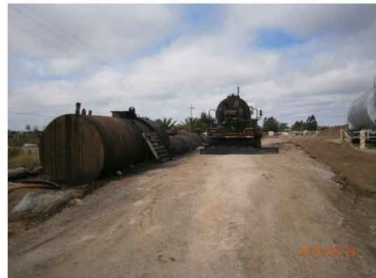
Ilustración 8 - tanques de diluido asfáltico
