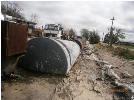
Ilustración 7 - tanques de diluido asfáltico
