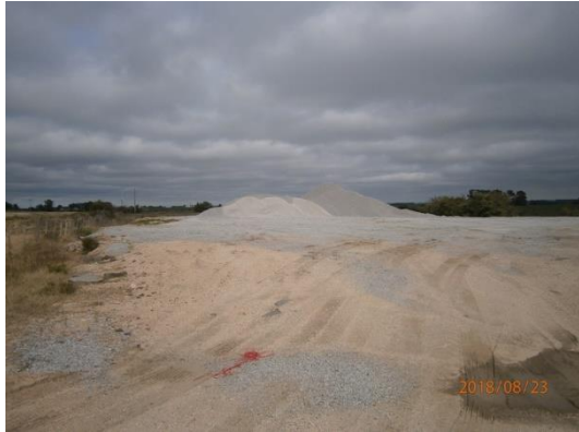
Ilustración 5 - zona de depósito de áridos
