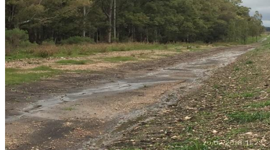
Ilustración 5 – Tramo de obra; faja acondicionada
