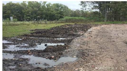
Ilustración 7 – Sector desmontado de acopio de diluido asfáltico
