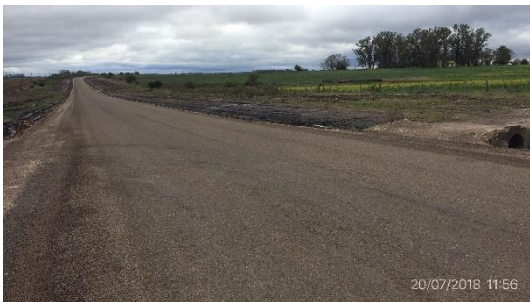
Ilustración 6 - Tramo de obra terminado
