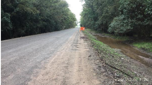
Ilustración 4 – Tramo de obra terminado
