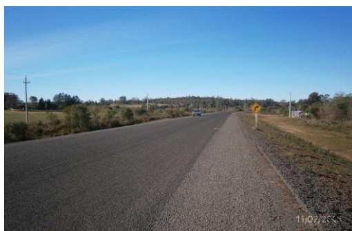
Ilustración 6 – frente de obra.
