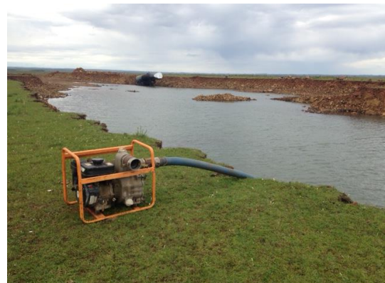
Ilustración 9 - Cantera, motobomba para extracción de agua.
