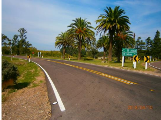
Ilustración 10 - Tramo de obra en Ruta 13.
