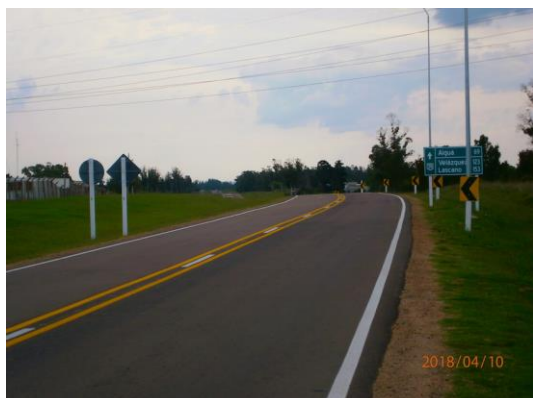
Ilustración 4 - Tramo de obra en Ruta 39.
