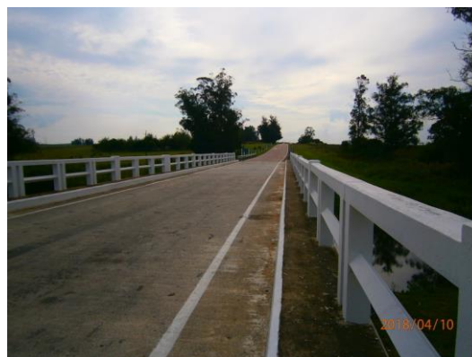
Ilustración 5 - Tramo de obra en Ruta 39.
