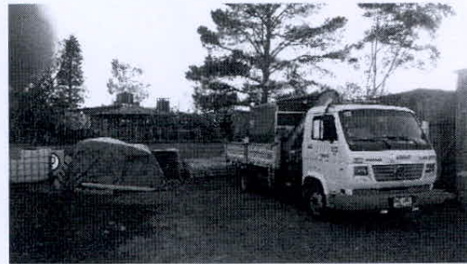
acopio de materiales y estacionamiento de equipos
