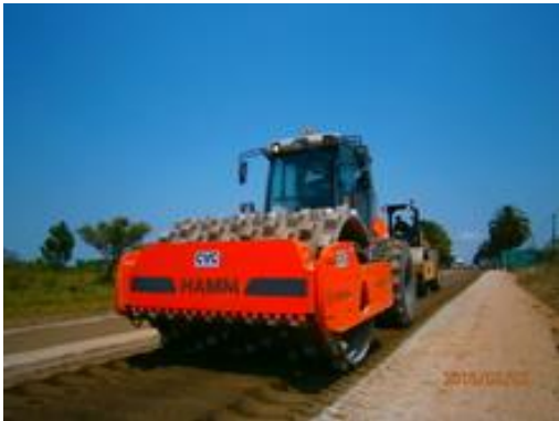
Ilustración 6- Frente de obra
