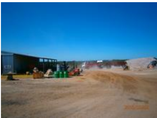
Ilustración 8- Vista del obrador
