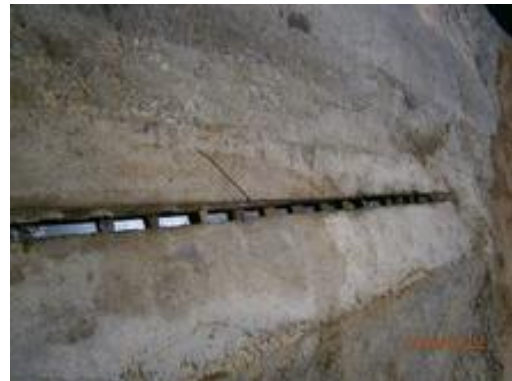
Ilustración 13- Canaletas de talleres
