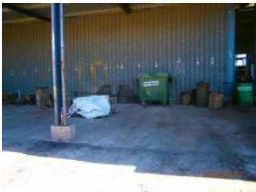
Ilustración 14- Almacenamiento de residuos
