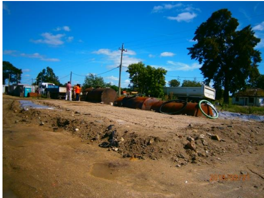
Ilustración 5 - Obrador, zona de carga de dilución asfáltica
