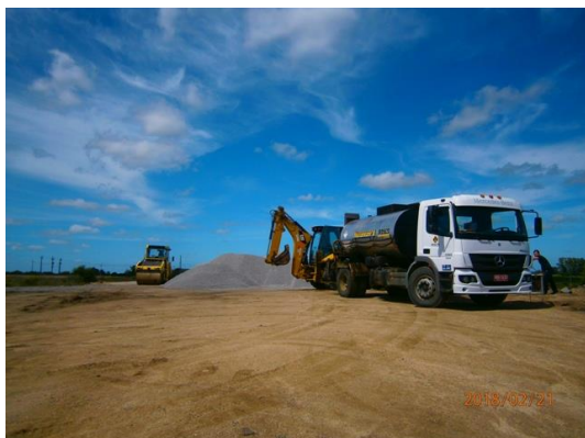
Ilustración 9 - Zona de acopio de áridos
