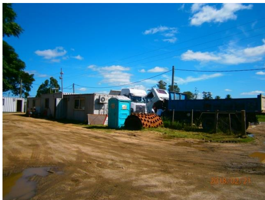
Ilustración 7 - Obrador, vista general
