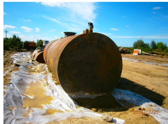
Ilustración 8 - Tanque con dilución asfáltica
