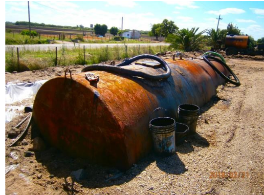
Ilustración 6 - Obrador, tanques con dilución asfáltica
