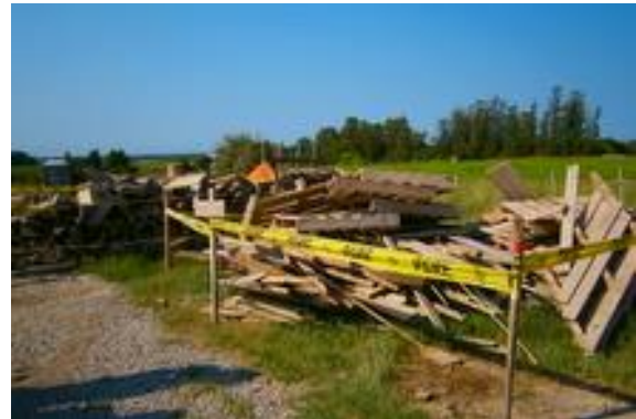
Ilustración 15 - Almacenamiento de distintos residuos con señalización por zonas
