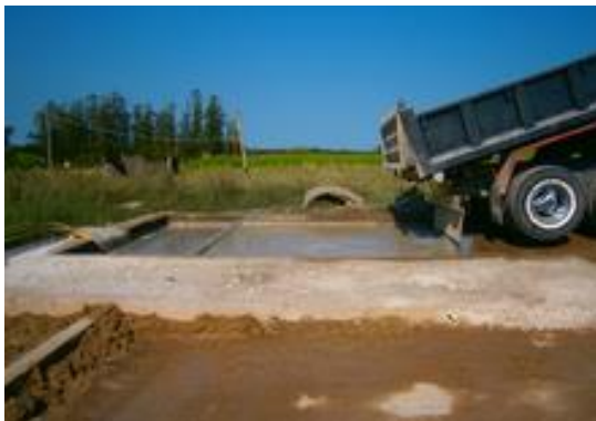
Ilustración 8 - Lavados de camiones con hormigón.
