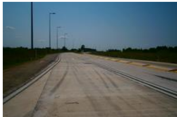
Ilustración 17 – Frente de obra finalizado (sobre Ruta 11).
