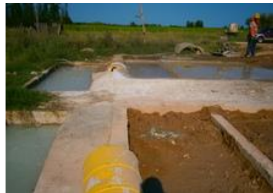
Ilustración 9 – Piletas para lavado de hormigón.
