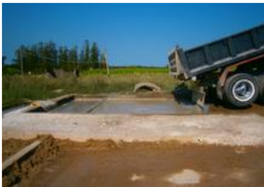
Ilustración 8 – Lavados de camiones con hormigón.
