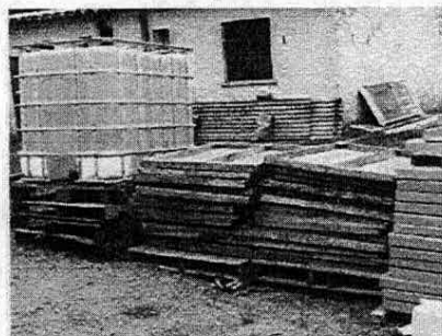
materiales (en uso) en el exterior del depósito
