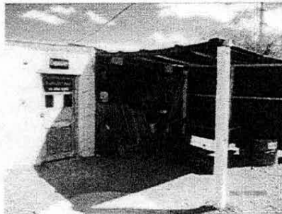
vista exterior depósito de Mariscalca
