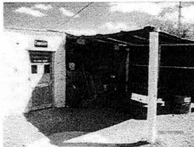
vista exterior depósito de Mariscalá
