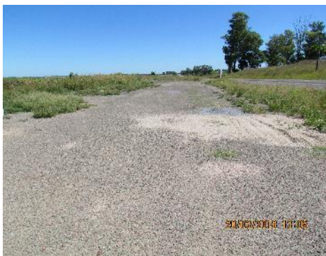
Ilustración 5 – Obrador provisorio desmantelado.
