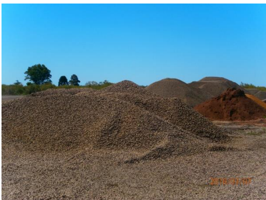
Ilustración 9 - Zona de acopio
