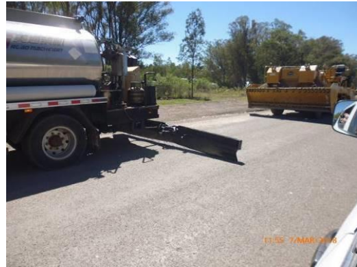
Ilustración 13 - Frente de obra: Riego de imprimación
