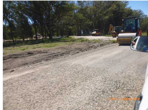
Ilustración 15 - Frente de obra: Agregados pétreos
