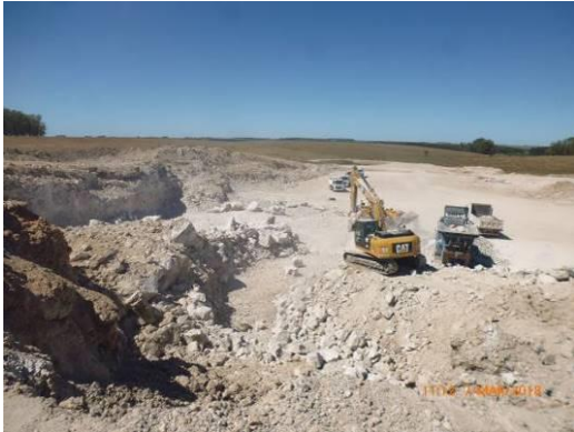
Ilustración 10 - Cantera de material granular.
