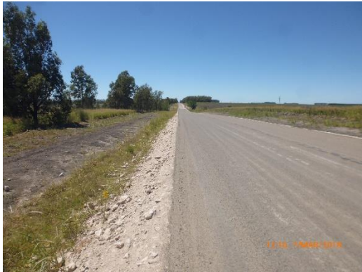
Ilustración 14 - Frente de obra: Imprimación con arena
