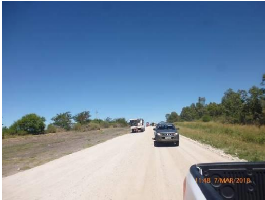
Ilustración 12 - Frente de obra: Terminación de la base
