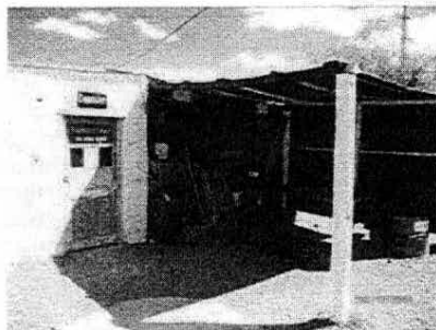
vista exterior depósito de Mariscalá
