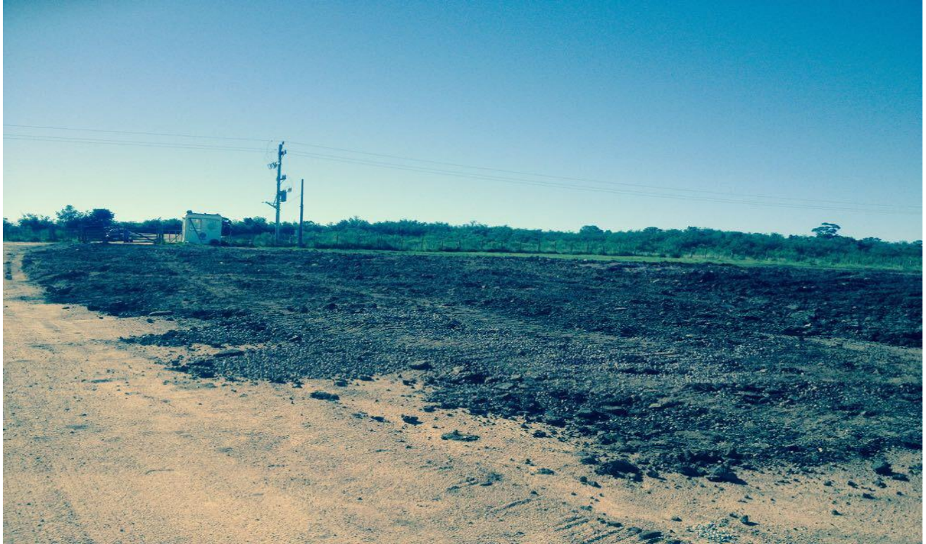
Área de acopios y campamento.
