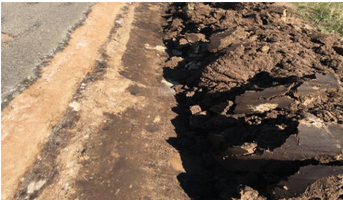
Nivelación de bases con Inspección. Ensanche zona de diente.
