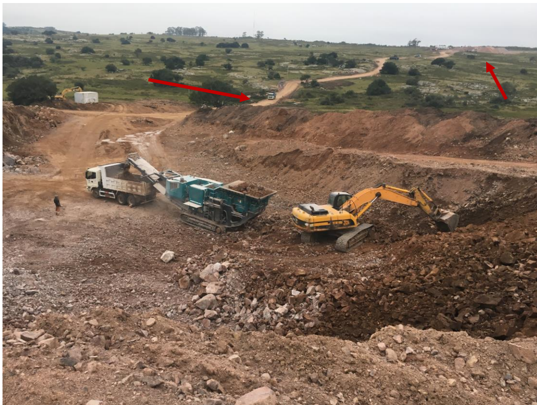
Camino desde la cantera al obrador, ángulo superior derecho zona de triturado y acopios. Se observa camino existente del establecimiento mejorado.
