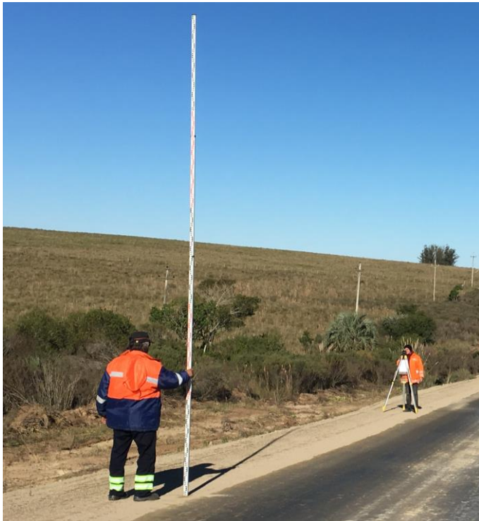
Nivelación de bases con Inspección. Ensanche zona de diente.
