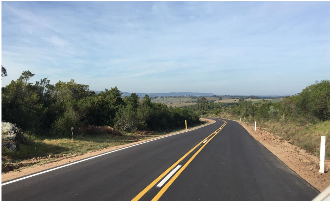
Frente de trabajo terminado.
