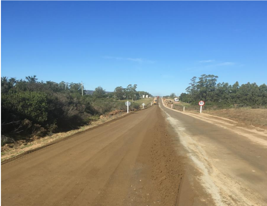
Terminado de bases cementadas.
