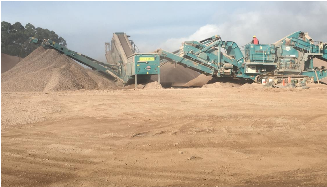
Trituradora en funcionamiento, no se observa polvo en suspensión
