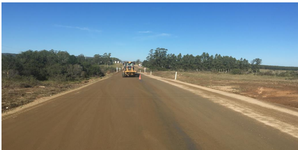
Terminado de bases cementadas.
