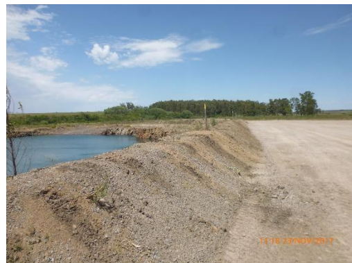
Ilustración 15 - Obrador Ruta 8, progresiva 237K000. Cantera de piedra.
