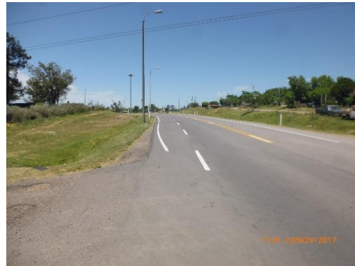
Ilustración 19 - Ruta 8. Accesos al puente Arroyo Corrales.
