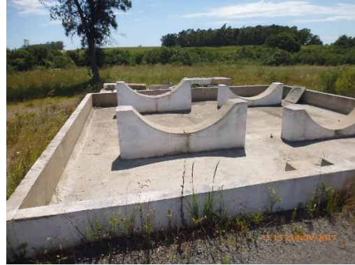
Ilustración 11 - Obrador Ruta 8, progresiva 237K000.
