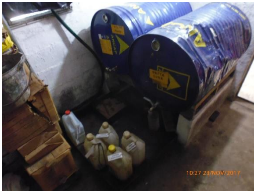
Ilustración 6 - Obrador. Mariscalá. Tanques de nafta.
