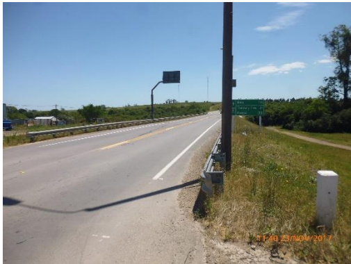
Ilustración 18 - Ruta 8. Accesos al puente Arroyo Corrales
