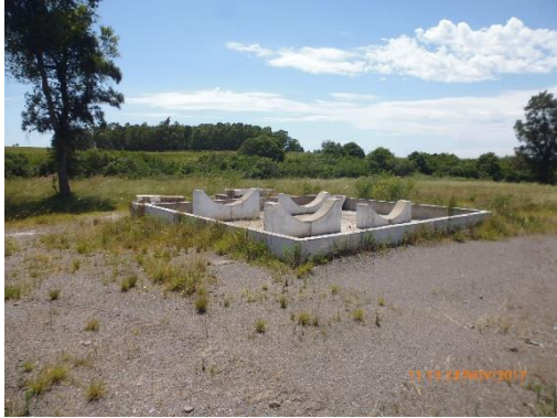
Ilustración 10 - Obrador Ruta 8, progresiva 237K000.
