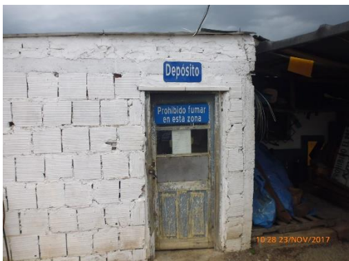
Ilustración 8 - Obrador. Mariscalá. Cartelería Prohibido fumar en depósito.
