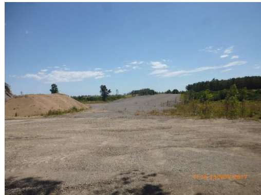
Ilustración 13 - Obrador Ruta 8, progresiva 237K000. Rampa.
