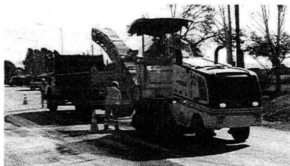
maquina y personal realizando trabajos de fresado
