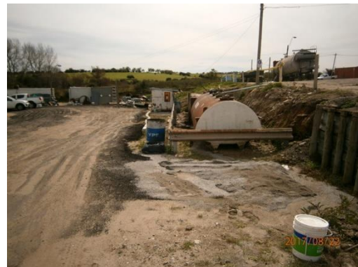
Ilustración 10 - Tanques de combustible.
