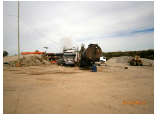
Ilustración 18 – Planta de asfalto operando.
