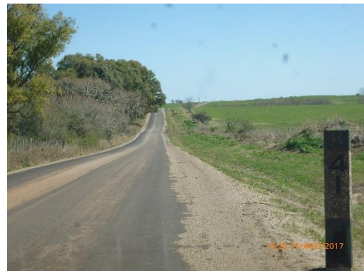
Ilustración 16 - Frente obras. Primer capa del tto bituminoso.
