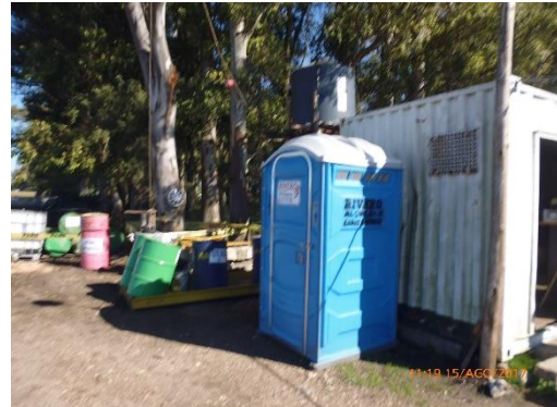
Ilustración 10 - Obrador. Baño químico.
