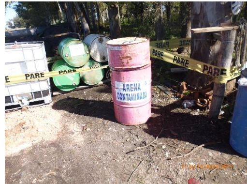
Ilustración 14 - Obrador. Tanque para arena contaminada.
