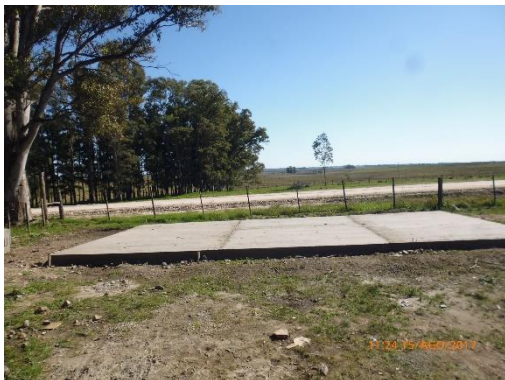
Ilustración 15 - Obrador. Losa de hormigón para acopio de diluido asfáltico en tanques.
