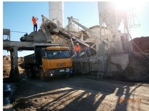
Ilustración 17 – Planta de hormigón operando.
