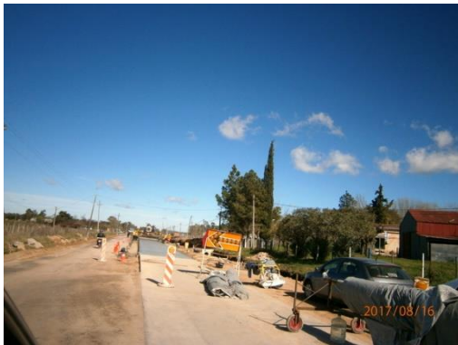
Ilustración 22 – Señalización sobre frente de obra.
