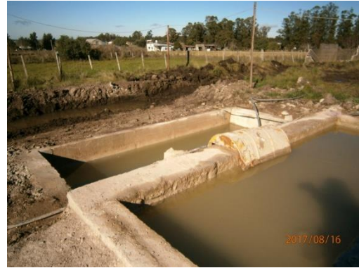
Ilustración 9 – Piletas para lavado de hormigón.
