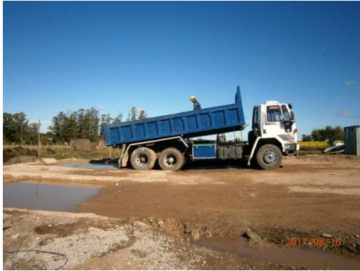
Ilustración 8 – Lavados de camiones con hormigón.
