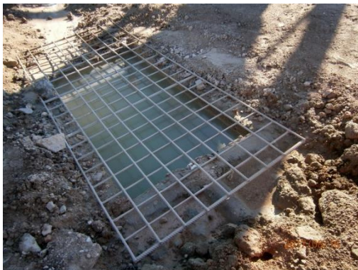
Ilustración 16 – Canalización para aguas de la planta.
