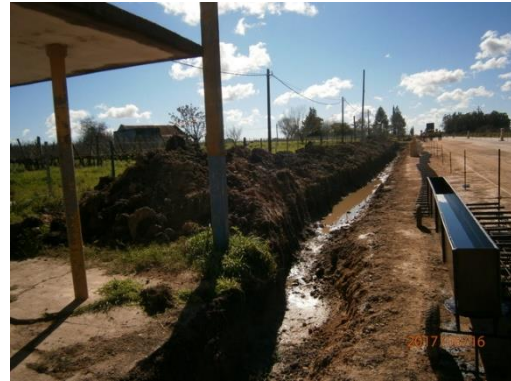
Ilustración 21 – Frente de obra.
