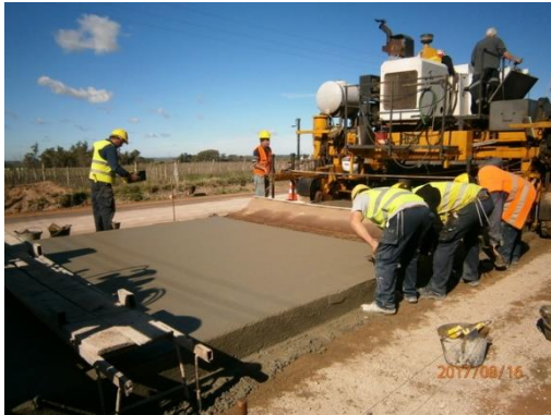
Ilustración 20 – Frente de obra.
