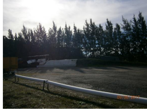
Ilustración 5-Al fondo se ve la plataforma construida para el tanque de combustible y que el tanque ha sido retirado
