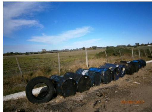
Ilustración 10-Acopio de tanques con asfalto para descartar. Los mismos ubicados en plataforma acondicionada para contener derrames
