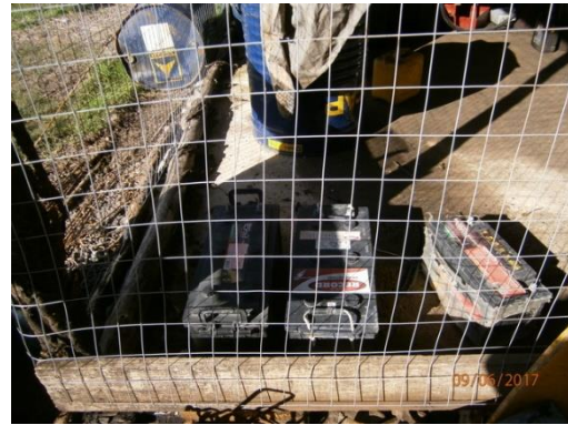
Ilustración 13-Almacenamiento de baterías en desuso y aceites
