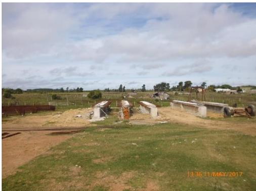
Ilustración 12 - Obrador. Zona de fabricación de vigas y piezas de hormigón. Suelo de tosca compactada.
