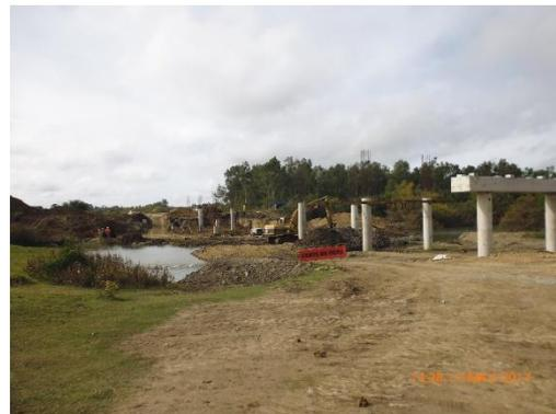
Ilustración 13 - Frente de obra. Pilares del nuevo puente. Arroyo Fraile Muerto.
