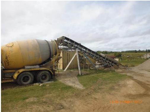
Ilustración 10 - Obrador. Camión mixer. Cinta de áridos. Tanque de agua. Plataforma elevada para operarios.
