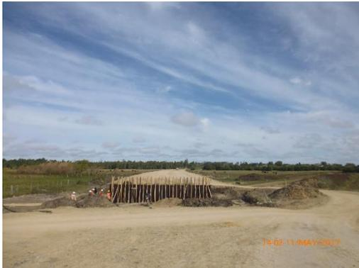
Ilustración 16 - Frente de obra. Alcantarilla H de una boca.
