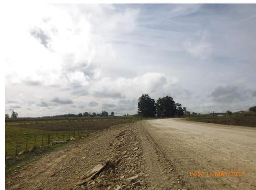
Ilustración 15 - Frente de obra. Base granular de acceso norte.
