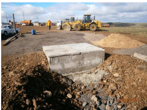
Ilustración 14 - Camara separadora en construccion
