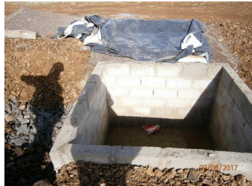
Ilustración 13 - Camara separadora en construccion
