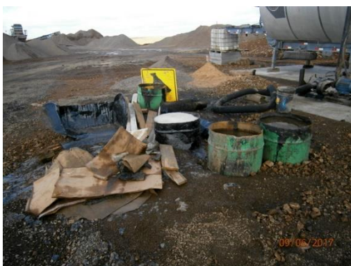
Ilustración 8 - Zona de trasiego en planta asfáltica.
