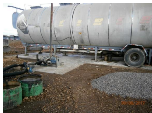
Ilustración 9 - Planta asfáltica con plataforma en construcción
