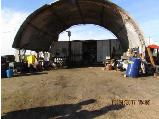
Ilustración 11 - Obrador nuevo. Taller para mantenimientos de maquinaria y otros.
