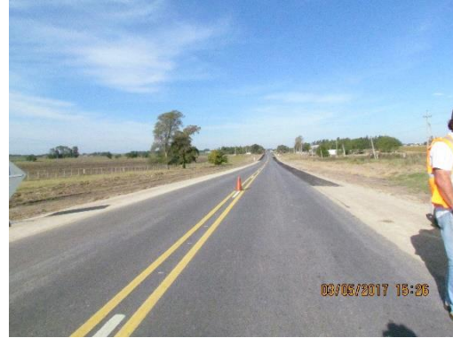
Ilustración 6 - Frente de obra. Material granular en y tratamiento bituminoso en banquetas.
