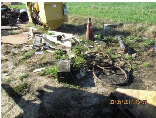
Ilustración 13 - Obrador nuevo. Baterías acopiadas sin orden y sobre el suelo.
