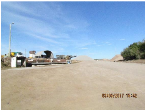
Ilustración 7 - Obrador nuevo. Entrada al obrador. Base de tosca. Pendiente pronunciada hacia la entrada.
