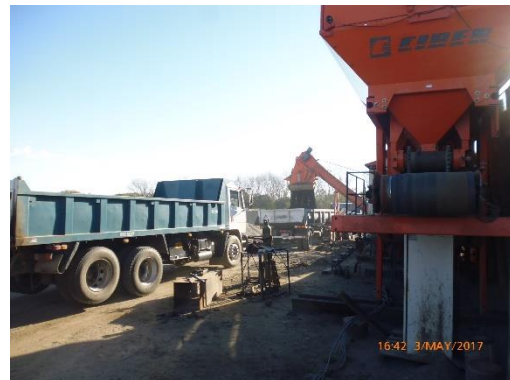
Ilustración 20 - Obrador nuevo. Planta de asfalto y camión para carga
