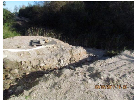
Ilustración 26 - Obrador nuevo. Erosión hacia Arroyo Melo por descarga de pluviales
