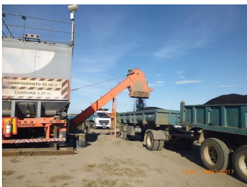
Ilustración 21 - Obrador nuevo. Planta de asfalto y camión para carga
