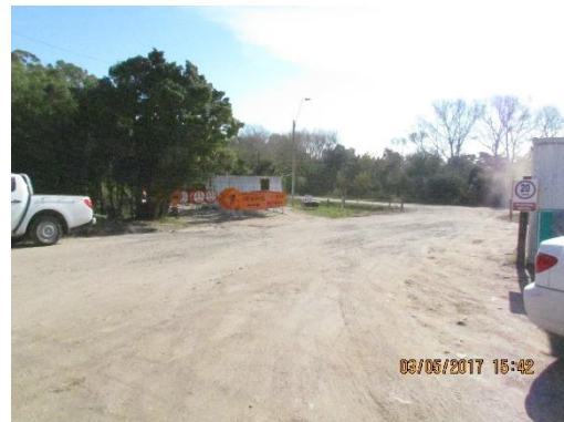
Ilustración 8 - Obrador nuevo. Baños a la entrada al obrador. Pendiente pronunciada hacia la entrada.
