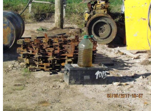
Ilustración 12 - Obrador nuevo. Baterías acopiadas sin orden y sobre el suelo. Bidón de aceite sobre batería.
