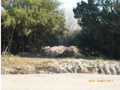
Ilustración 23 - Obrador nuevo. Perímetro a menos de 10 metros del Arroyo Melo
