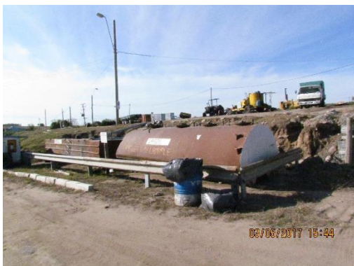
Ilustración 9 - Obrador nuevo. Tanques de combustible sin contención perimetral ni impermeabilización del suelo
