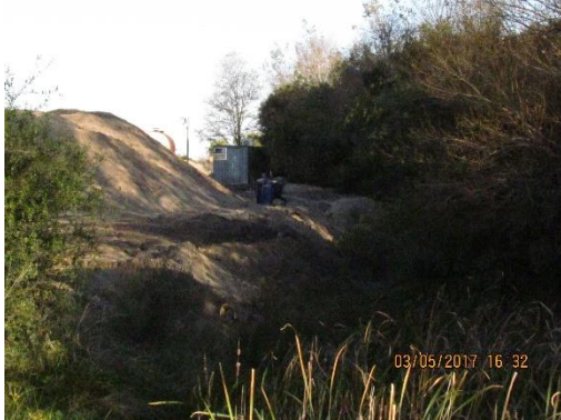
Ilustración 29 - Obrador nuevo. Acopios de áridos y oficina sobre margen del Arroyo Melo
