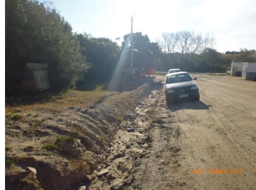
Ilustración 24 - Obrador nuevo. Cuneta de drenaje pluvial
