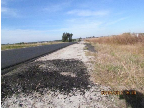
Ilustración 5 - Frente de obra. Refuerzo asfáltico en calzada y material granular en banquetas.
