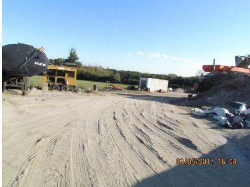
Ilustración 17 - Obrador nuevo. Izquierda: tanque de asfalto y generador a gasoil. Derecha: acopios de áridos y planta asfáltica.
