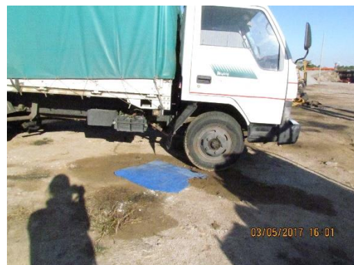
Ilustración 16 - Obrador nuevo. Derrame de hidrocarburos en el suelo
