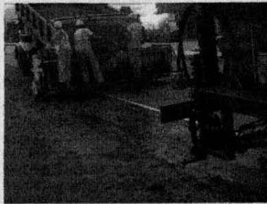
camión regador de asfalto, camión y gravilladora de agregados realizando un tratamiento bituminoso en las banquetas
