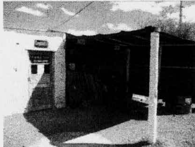
vista exterior depósito
