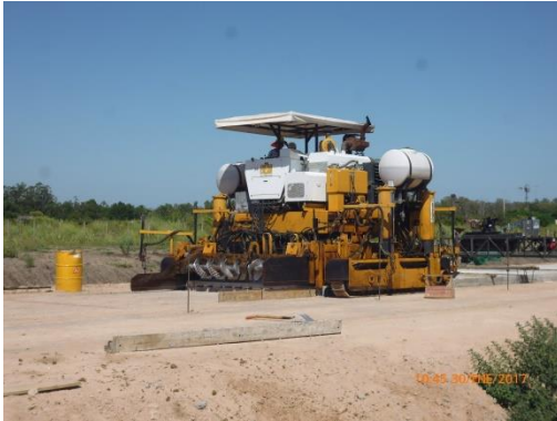
Ilustración 4 - Frente de obra
