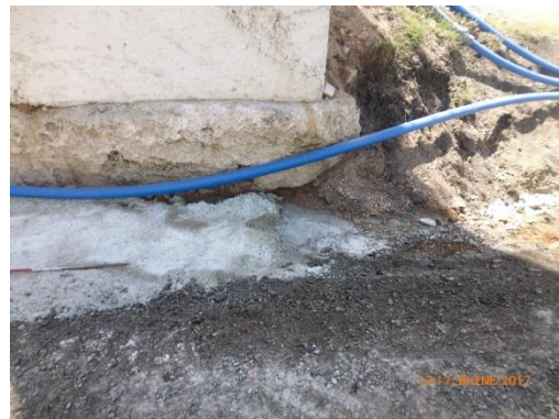
Ilustración 19 – Zona de vertidos de hormigón
