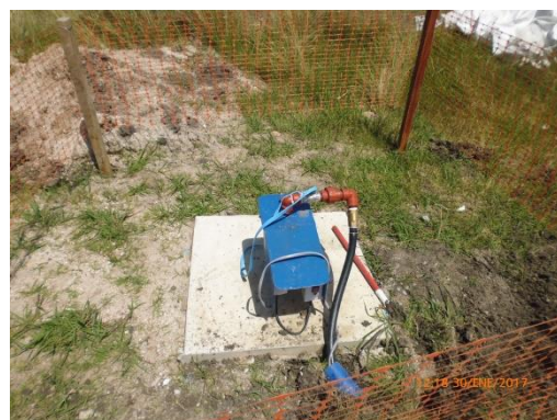
Ilustración 21 – Perforación para extracción de agua subterránea
