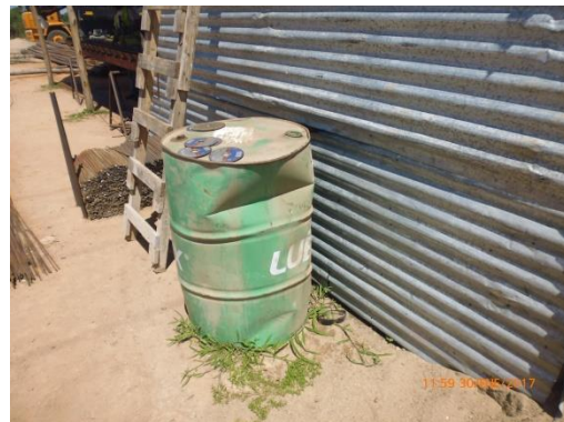
Ilustración 13 - Productos químicos sin contención
