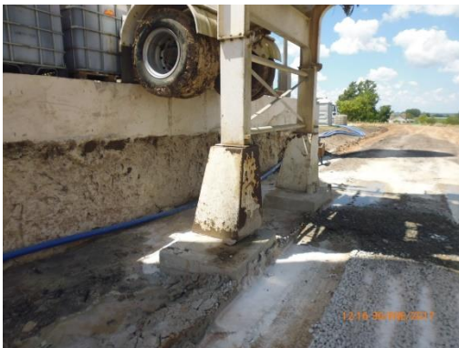
Ilustración 18 – Planta de hormigón, se observa vertido de hormigón
