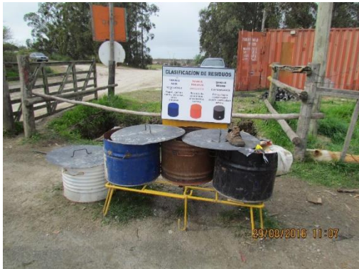
Ilustración 4 – Contenedores de residuos en el campamento. Tapados de manera inadecuada.
