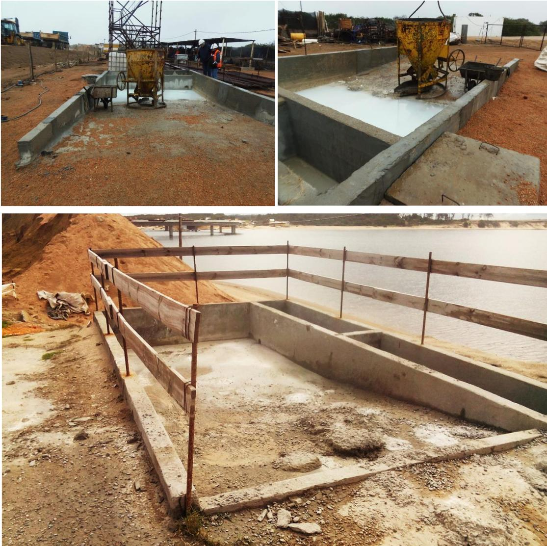
Figura 4-2 Pileta de lavado de mixer lado Oeste (imágenes superiores) y lado Este (imagen inferior)
