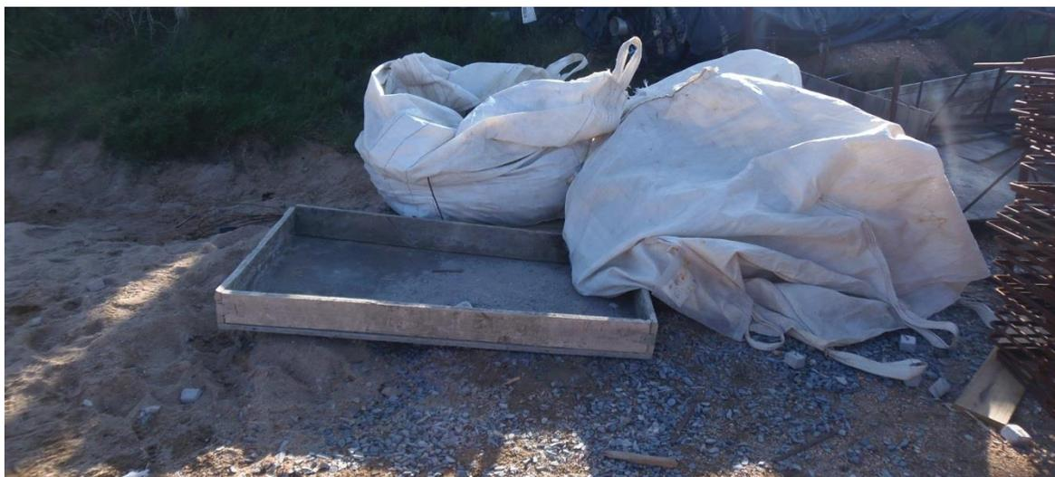
**Figura 4-2 Acopio de cemento protegido, bandeja para uso bajo hormigonera**
