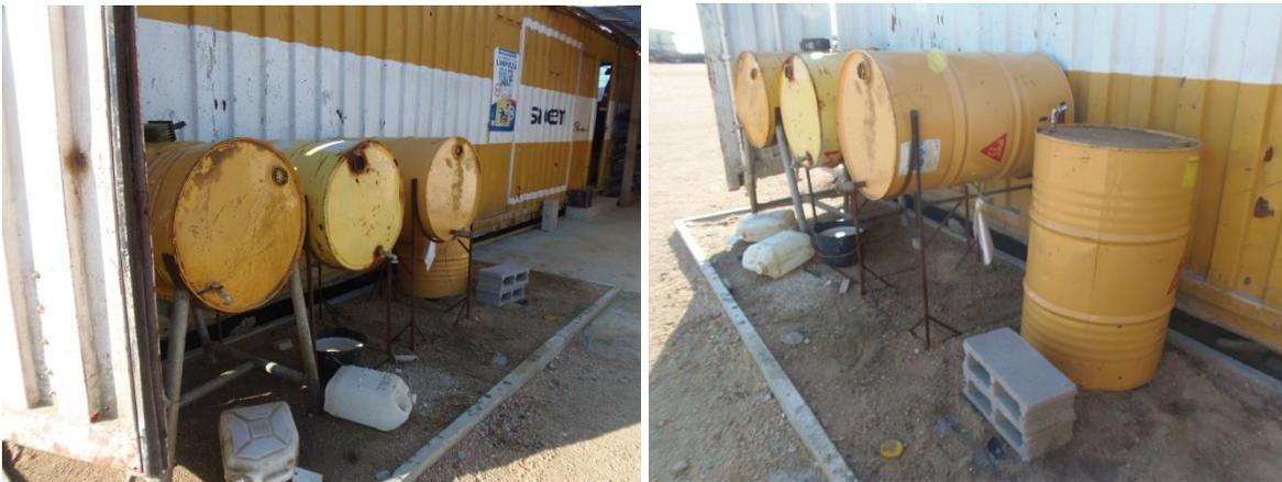
Figura 4-1 Acopio de sustancias peligrosas sobre bandejas de contención
