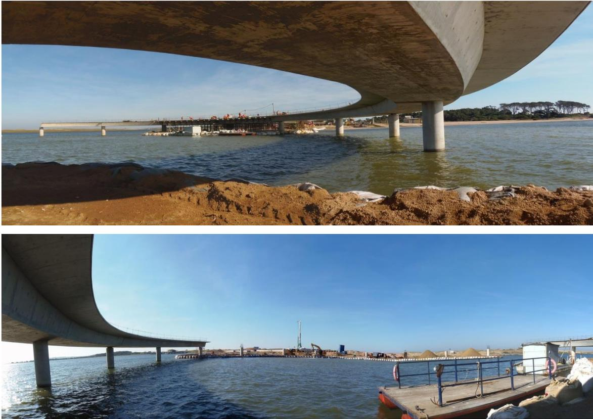
Figura 2-1 Ejecución de pilares, montaje de prefabricados
