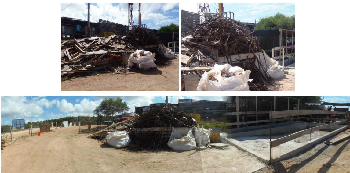
Figura 6-1 Acopio transitorio de residuos
