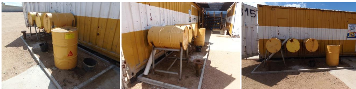
Figura 4-1 Acopio de sustancias peligrosas sobre bandejas de contención
