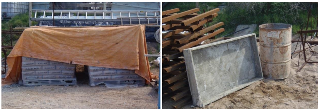
Figura 4-2 Acopio de cemento protegido, bandeja para uso bajo hormigonera
