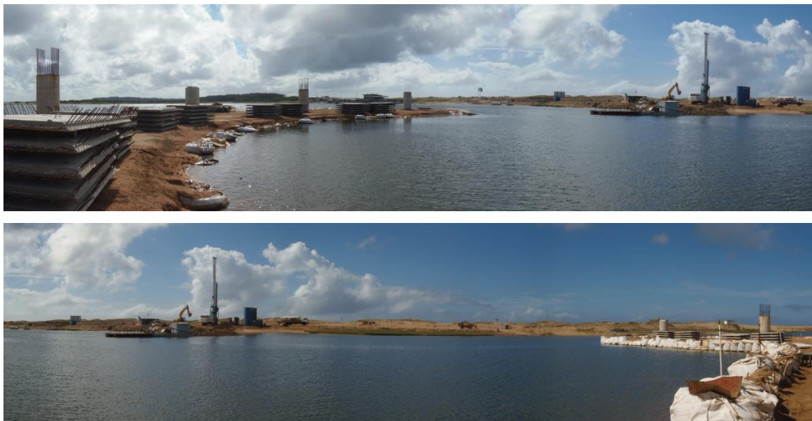
Figura 2-1 Ejecución de pilares, ejecución de prefabricados
