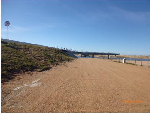
Ilustración 4 – Zona donde se ubicaba el obrador.
