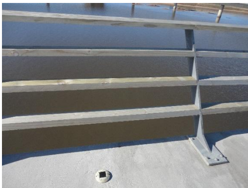
Ilustración 6 – Vereda y baranda interior. Contrato AB17.
