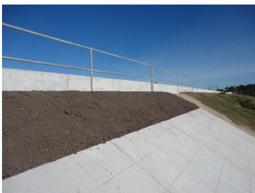
Ilustración 8 – Terminación del revestimiento. Zona a vegetar.
