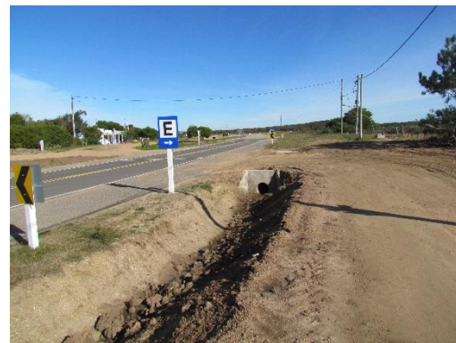
Ilustración 7 – Acceso al estacionamiento bajo el puente.
