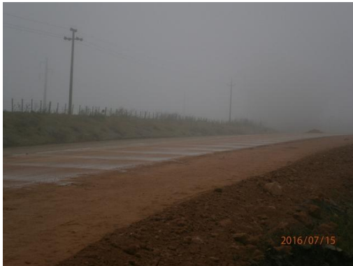
Ilustración 12-Frente de obra sobre Ruta 12
