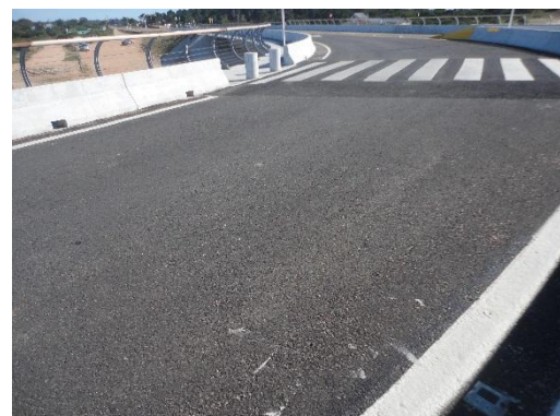
Ilustración 9 – Capa de rodadura. Rubro ejecutado por Traxpalco en el puente.
