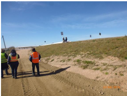
Ilustración 6 – Terraplén de acceso al puente.
