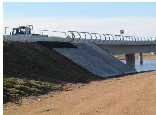
Ilustración 7 – Terraplén de acceso al puente.
