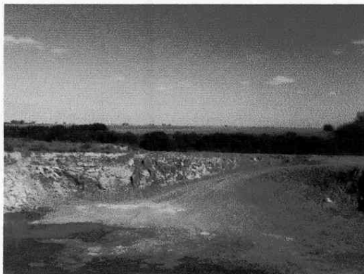
vista de la rampa de acceso a la cantera
