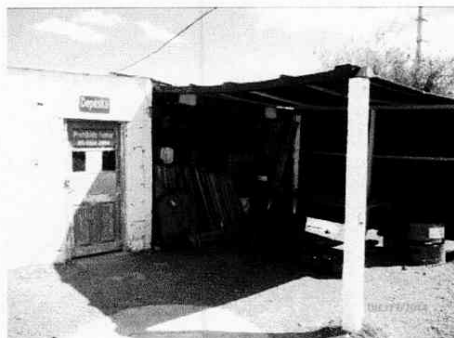
vista exterior depósito
