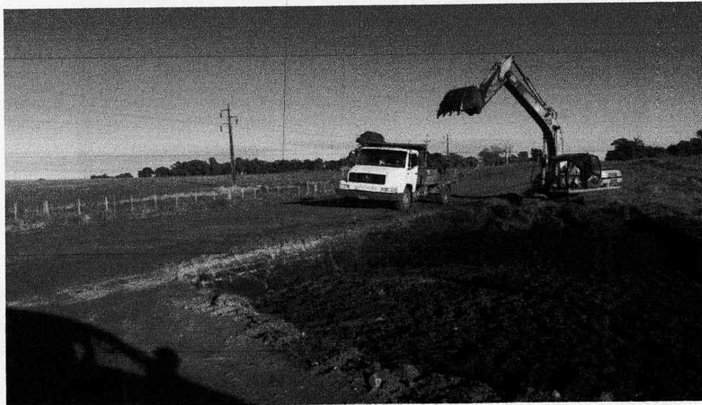
Tareas de ensanche de plataforma y sustitución de material no apto.
