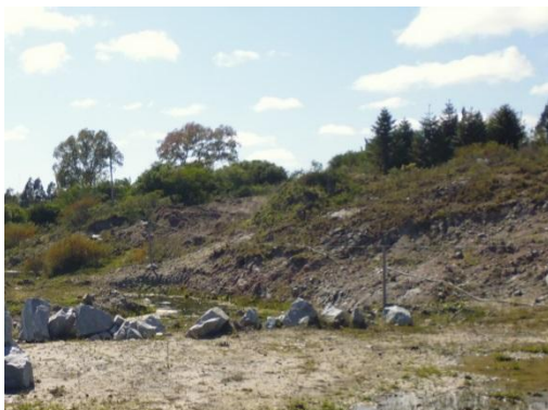
Ilustración 21 – Cañada de la que se extrae agua para el obrador.
