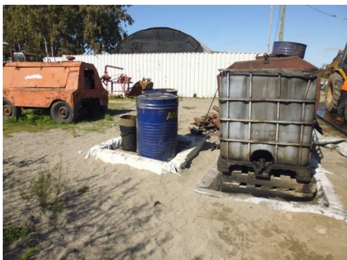
Ilustración 9 – Se construyeron contenciones a los tanques de hidrocarburos.
