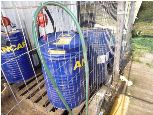
Ilustración 25 – Depósito con contención.
