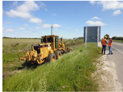
Ilustración 26 – Frente de obra.
