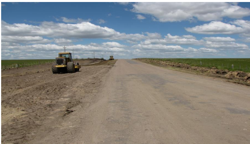
Compactación de los terraplenes de asiento del paquete estructural.
