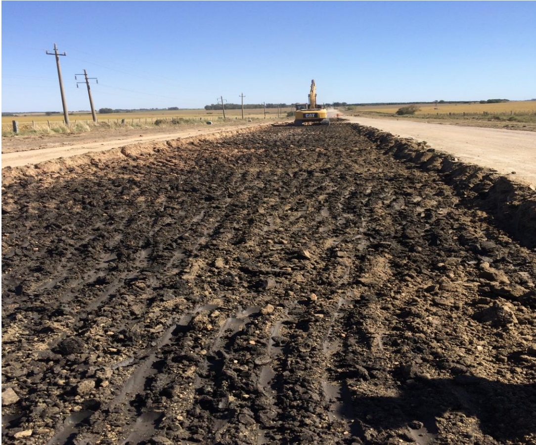
Sustitución de material no apto en el ensanche de carreteras.
