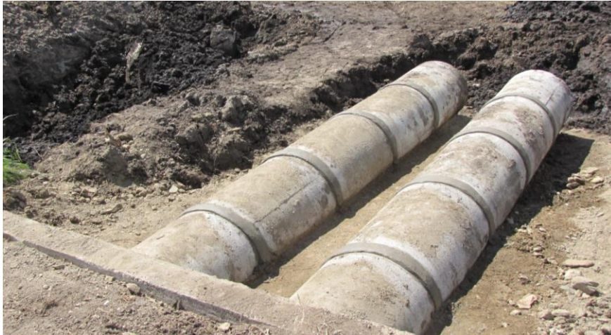
Prolongación de alcantarillas.
