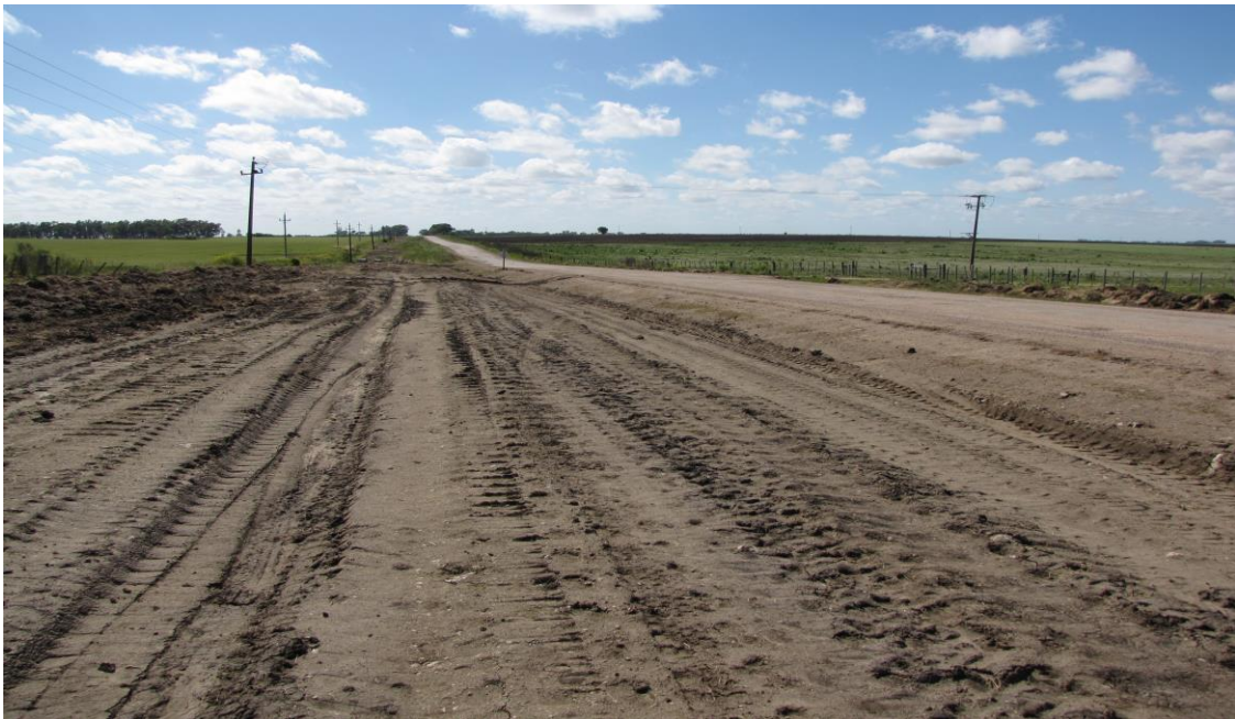
Limpieza de faja lateral previo a la conformación del diente de ensanche.
